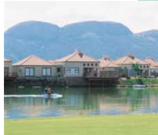
Afrique du Sud - Toiture Pecanwood Estate, Hartebeespoort Dam. Tuiles "Riviera Terracotta Farmhouse"
