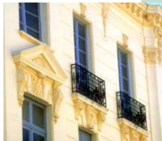
France Mortiers de façade utilisés en rénovation.
