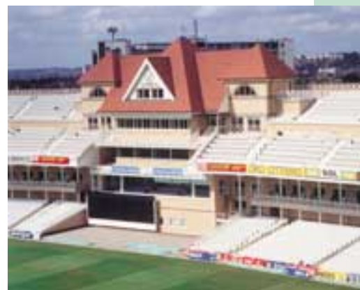
Royaume-Uni - Toiture Terrain de cricket de Trent Bridge à Nottingham.
